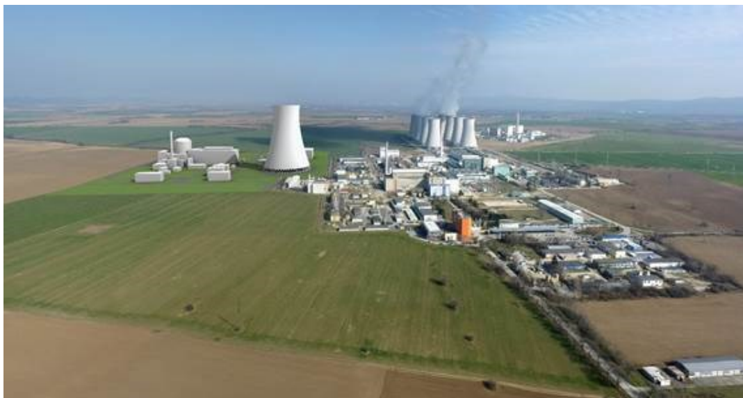
Obr. C.III.10: Celkový pohľad na areály NJZ a EBO
